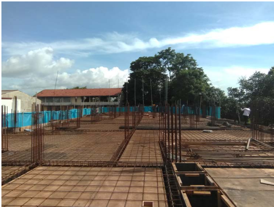
3 rd Floor Slab (Zone A)
