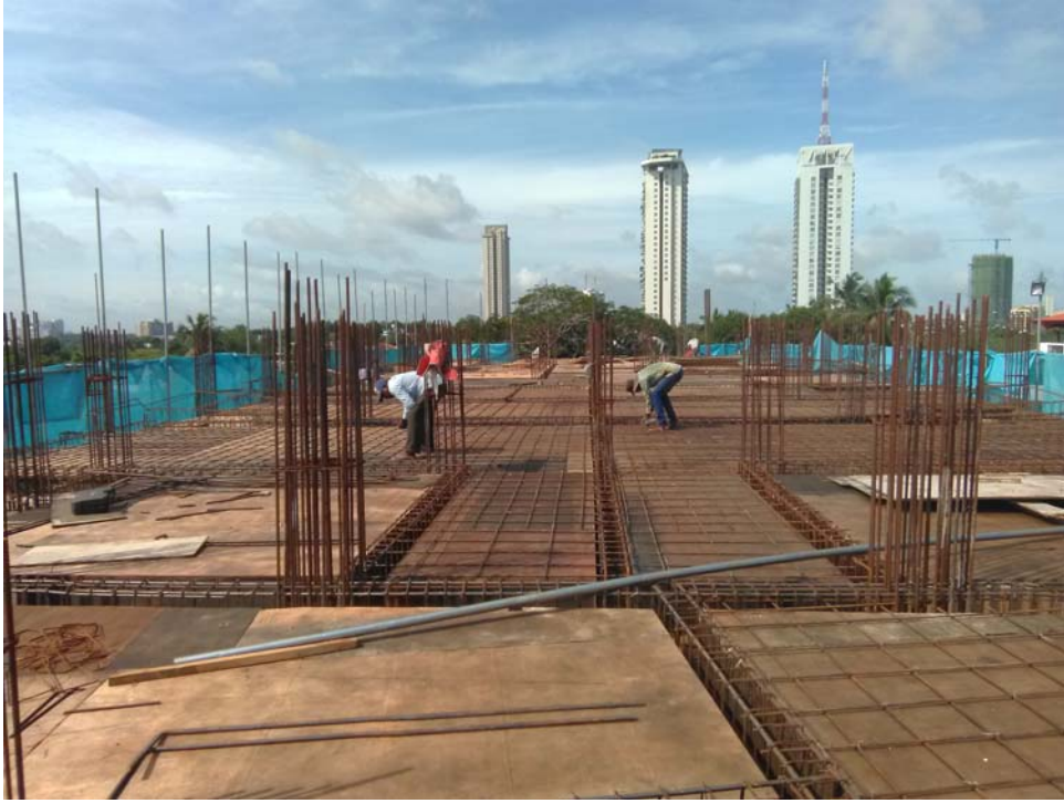
3 rd Floor Slab (Zone B)
